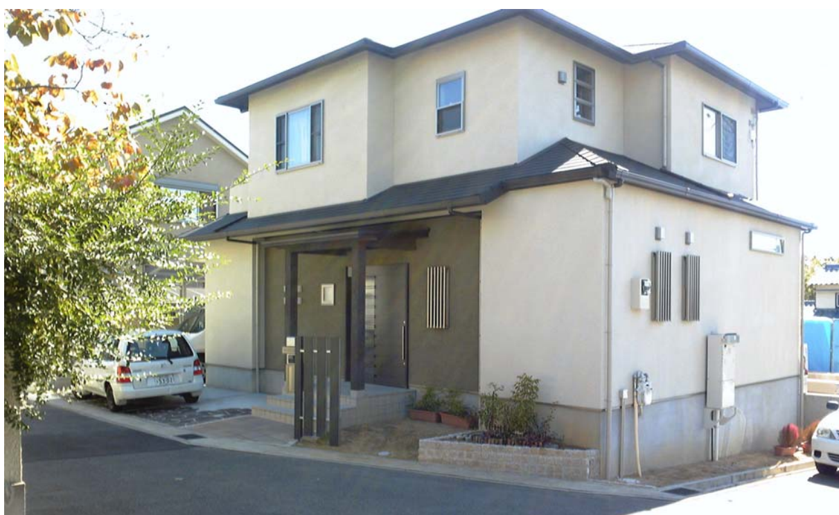
外観全景(北面)
